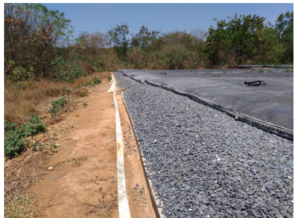
Foto 04. Armazenamento de lodo removido da lagoa anaeróbica
