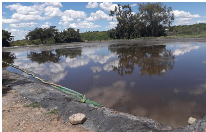
Foto 14. Lagoa anaeróbica após remoção do material flotante.
