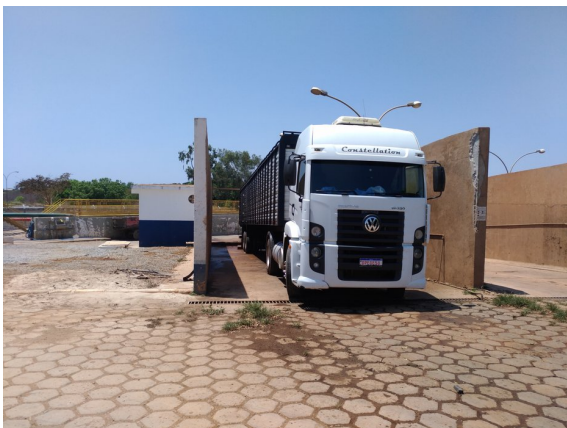
Foto 03. Lavador de caminhões gaiola
