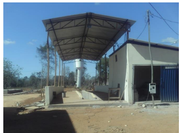
Foto 04. Lavador de veículos
