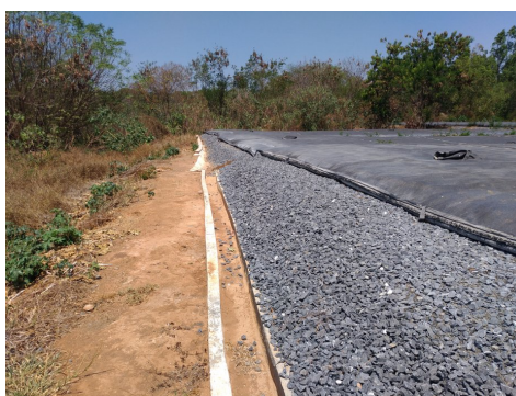
Foto 04. Armazenamento de lodo removido da lagoa anaeróbica
