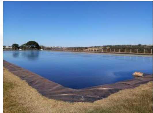
Foto 04. Lagoa da ETE
