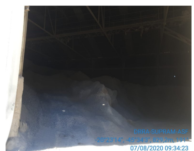
Foto 04. Parte interna dos silos
