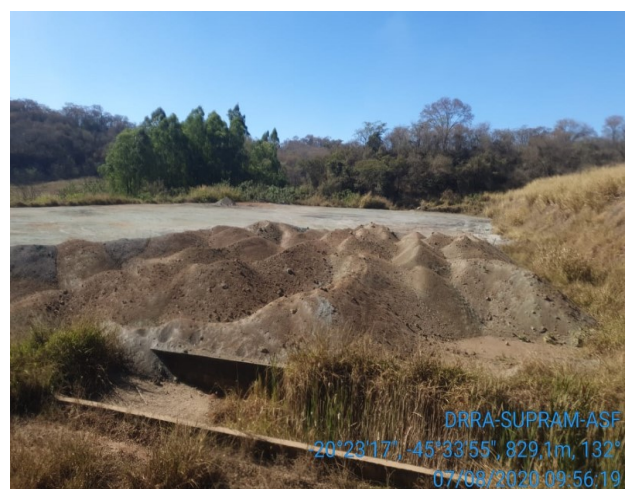
Foto 02. Pátio para armazenamento de resíduos
