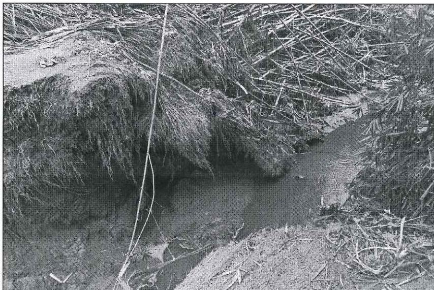
**Foto 1.** Aspecto do rompimento de parte do barramento ocasionado pela passagem da "tromba d'água".
