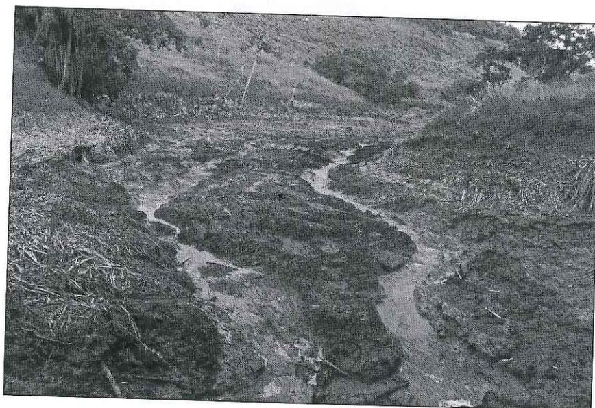
**Foto 3.** Vista da área do lago após o rompimento de parte do barramento, resultando na degradação ambiental da área (solo e fauna aquática).
