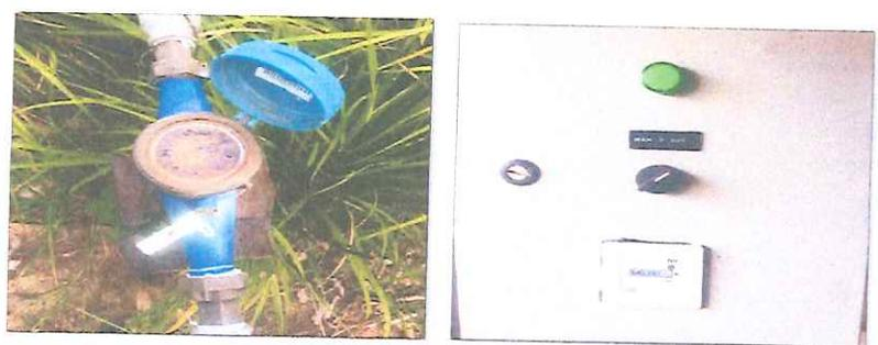
Figura 8 - Horímetro e Hidrômetro do poço.
