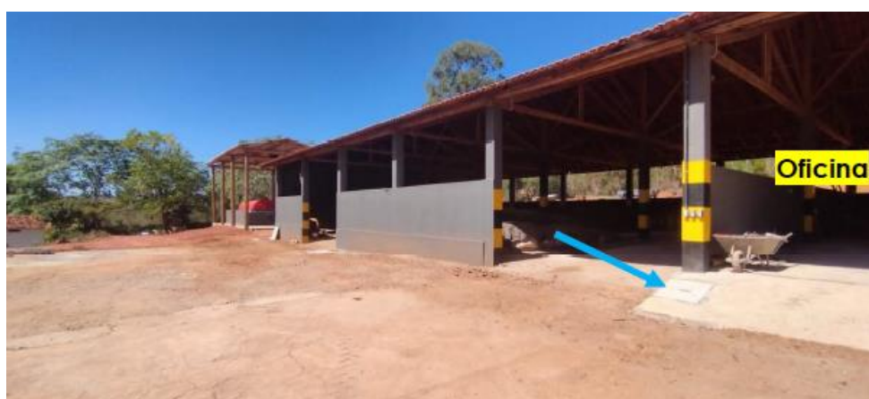
O galpão na Fazenda Caiçara foi recentemente subdividido e submetido a melhorias. Na foto acima, a seta indica a caixa de passagem da tubulação conectada à caixa SAO. É importante ressaltar que a geração de efluentes líquidos é bastante reduzida, ocorrendo apenas durante a limpeza do piso da oficina.
