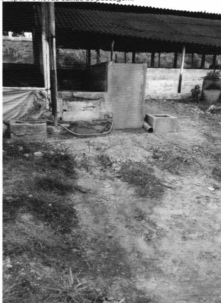
Figura 06: Obras de reparo e novas caixas de passagem.
