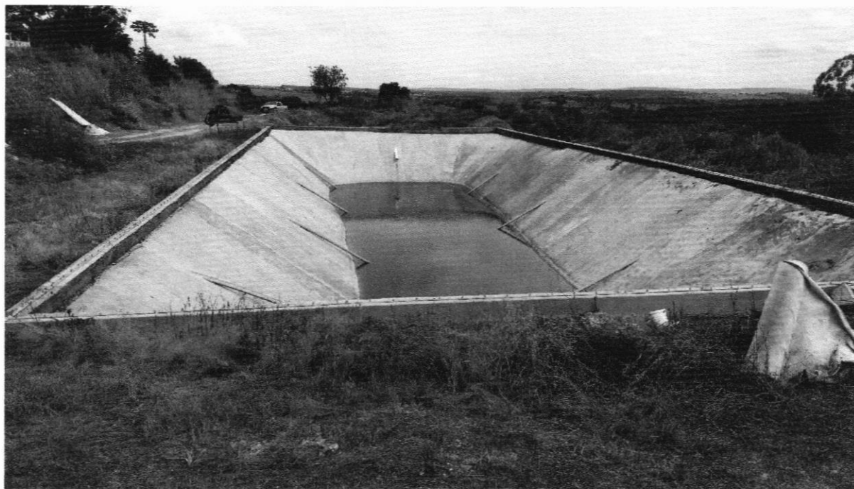
Figura 10: Imagens do biodigestor em construção no empreendimento.
