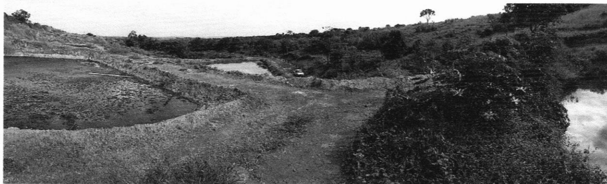
Figura 02: Foto panorâmica ilustrando a última lagoa de dejetos (esquerda) próxima a uma cacimba (direita) construída pelo proprietário para direcionamento pluvial, e ao fundo uma das bacias de acumulação facultativas.
