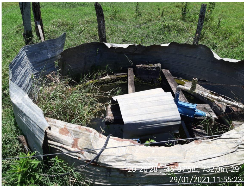
Figura 7. Poço manual (cisterna)
