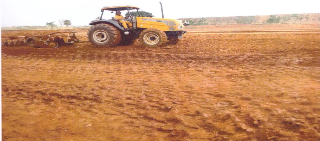
FOTO 4: VISTA GERAL DOS TRABALHOS DE HOMOGENEIZAÇÃO DE SOLO.
