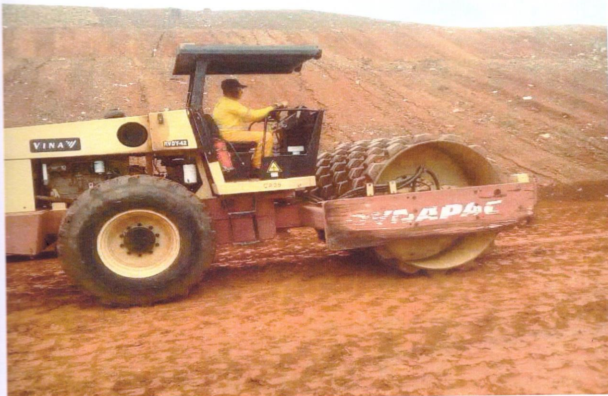
FOTO 5 : COMPACTAÇÃO DE CAMADA IMPERMEABILIZANTE.
