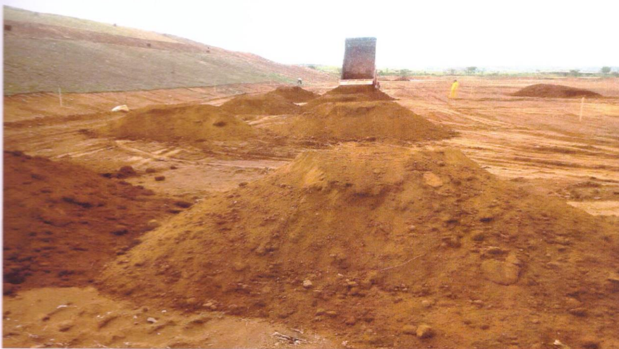
FOTO 2: LANÇAMENTO DE MATERIAL ARGILOSO PROVENIENTE DA JAZIDA 1.
