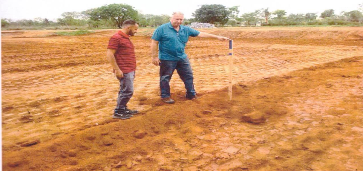
FOTO 3: VISTA GERAL DOS TRABALHOS.
