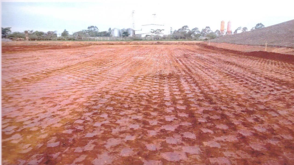
FOTO 8 : VISTA GERAL DO TRECHO APÓS OS SERVIÇOS DE COMPACTAÇÃO.
