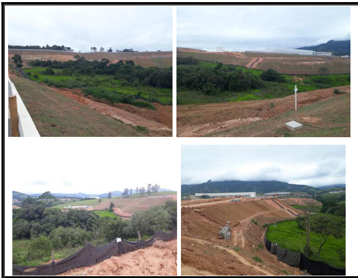
Figura 07: Fotos gerais da área do empreendimento em instalação.
