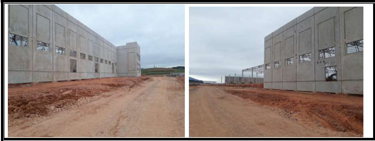
Figura 04: Fotos de parte dos galpões em construção.
