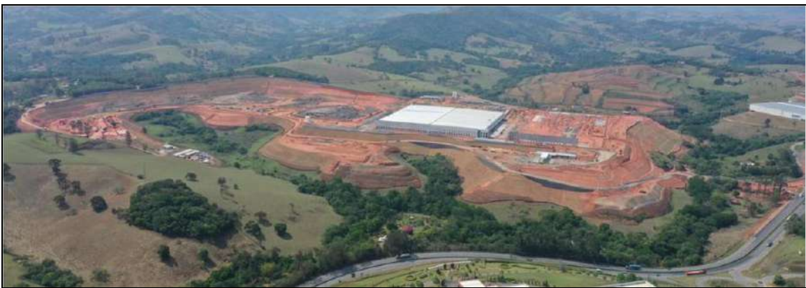
Figura 02: Imagem recente da instalação do empreendimento em análise (Fonte: INDI).
