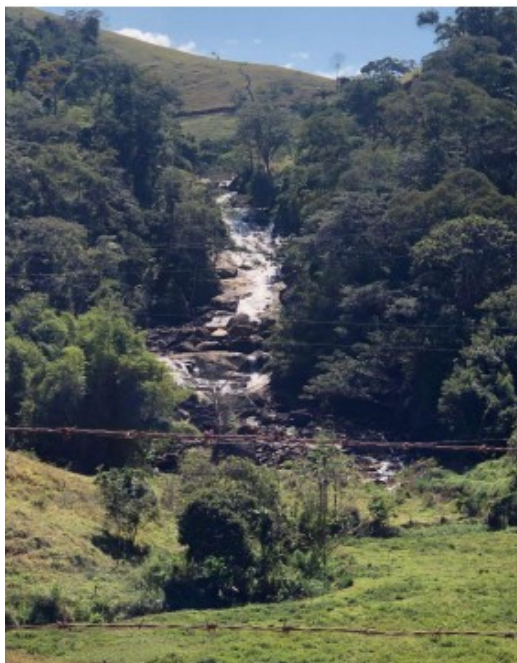
Figura 1 - Queda natural no rio Gavião, em que se encontra instalada a CGH Antônio Prado. Fonte: Documento SEI nº 75346946.
