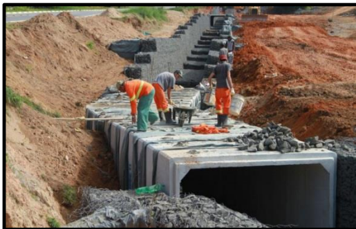
Canalização/retificação de curso d'água
