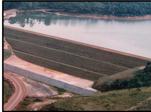
Barragem de contenção de rejeitos de mineração
