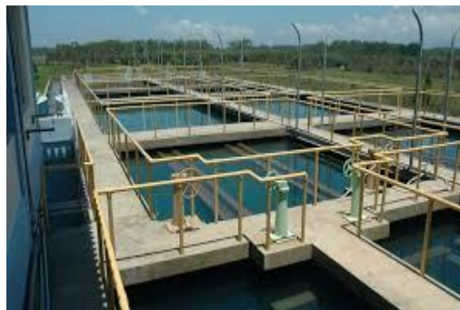
Estação de Tratamento de Água
