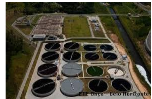
Estação de Tratamento de Esgoto
