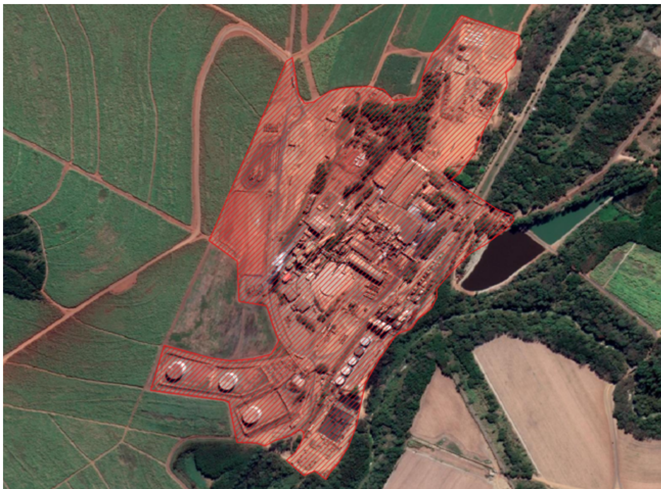
Figura 01 - Solo exposto na Área Diretamente Afetada (ADA), imagem do Google Earth, disponível no QuickMapServices.
