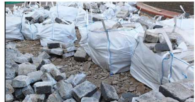
Figura 16 - Exemplo da utilização de sacos big bags em obra. Fonte: Elaboração própria, Consórcio IDP FR, 2015.
