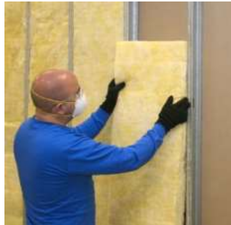
Manta de lã de vidro (utilizada para isolamento térmico e acústico)
