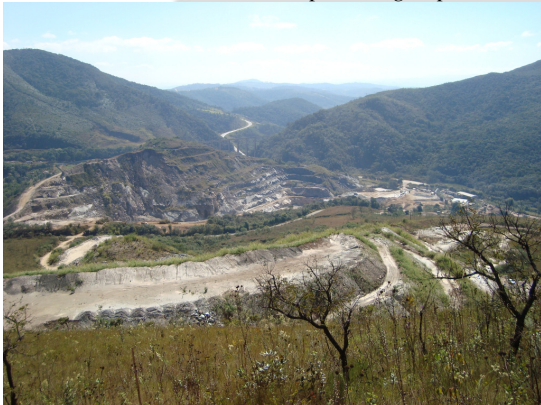
Foto 03. Vista da cava a partir da pilha.
