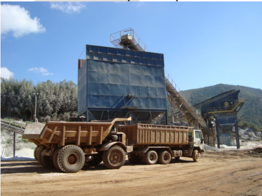
Foto 05. Carregamento de caminhão feito em silo.
