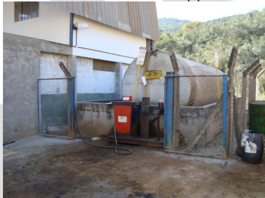
Foto 06. Sistema de abastecimento de veículos.
