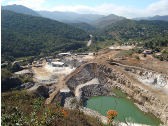
Foto 01. Vista da Cava e sump com água pluvial.
