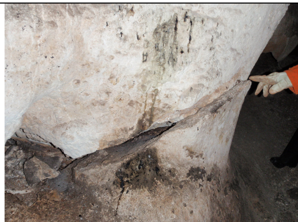
Foto 07. Trinca na parede da gruta Mata Grande I.
