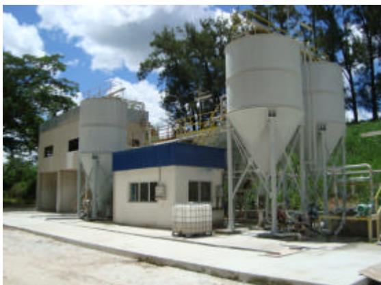
**Foto 07.** ETE industrial utilizada no reaproveitamento da torta no processo produtivo.
