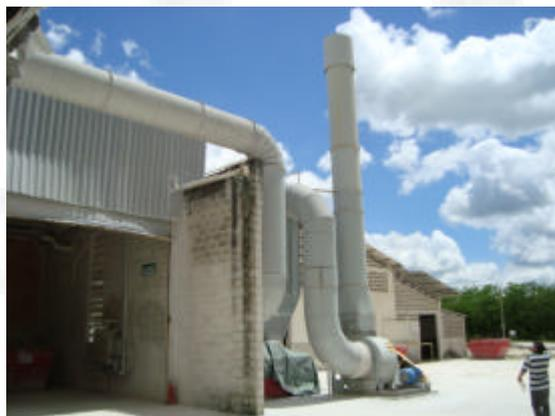
**Foto 10.** Filtro de manga utilizado na unidade de prensa.
