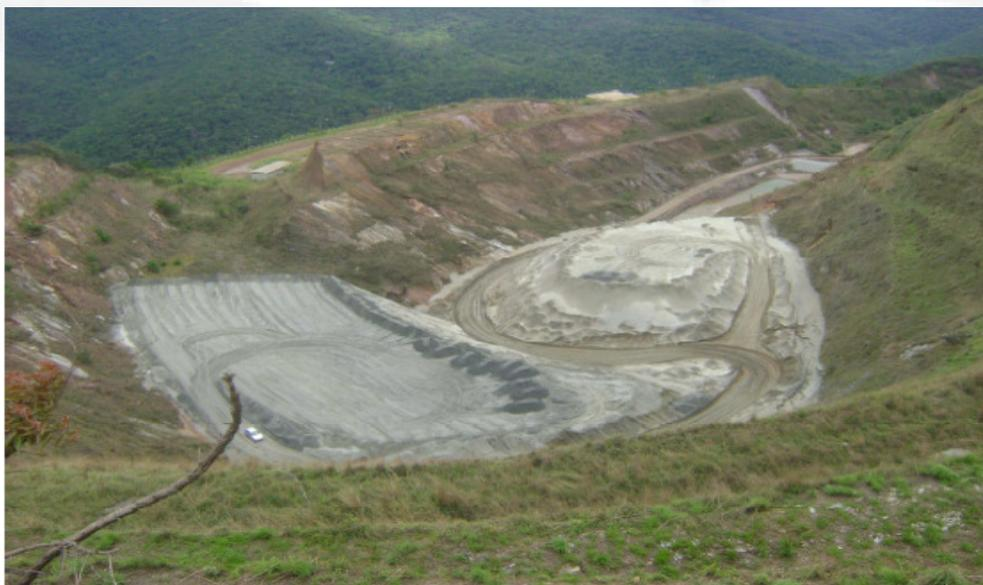
**Foto 02- Cava exaurida na Mina Cuiabá que será utilizada para disposição de materiais descartáveis (rejeitos e estéril) oriundos das operações da empresa.**
