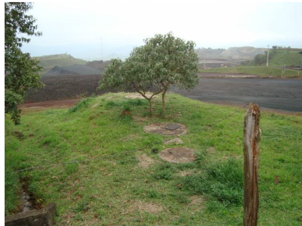
Foto 16. Sistema de fossa-filtro- sumidouro.
