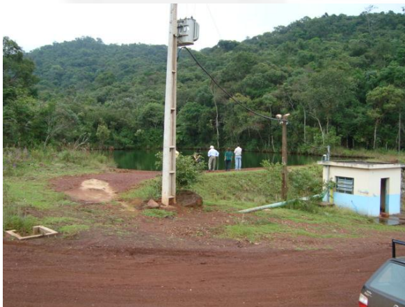
Foto 17. Barramento para captação de água.
