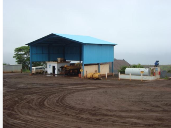
Foto 08. Oficina da foto 03 e tanque anterior.
