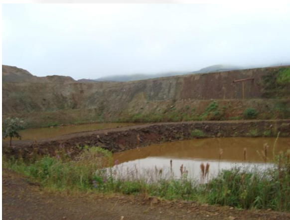
Foto 11. Sistema de contenção de rejeitos feito através de bacias.
