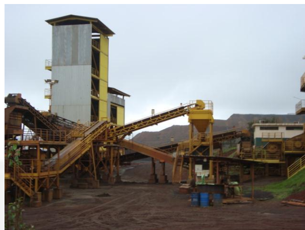
Foto 02. Detalhe da Planta de Beneficiamento.
