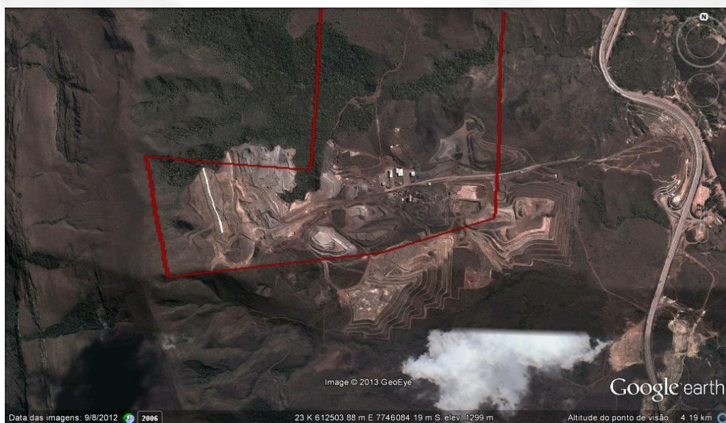
Figura 2: Detalhe do empreendimento (imagem anterior) com extremidade sul do polígono minérario, cava e estruturas da mina.
