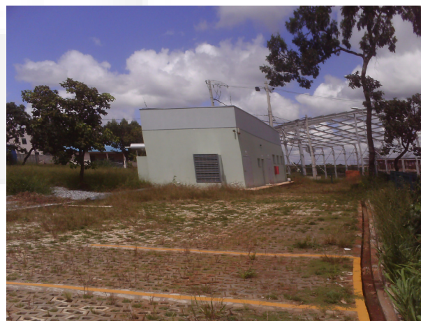
Figura 04: Depósito temporário de resíduos já pronto no local.
