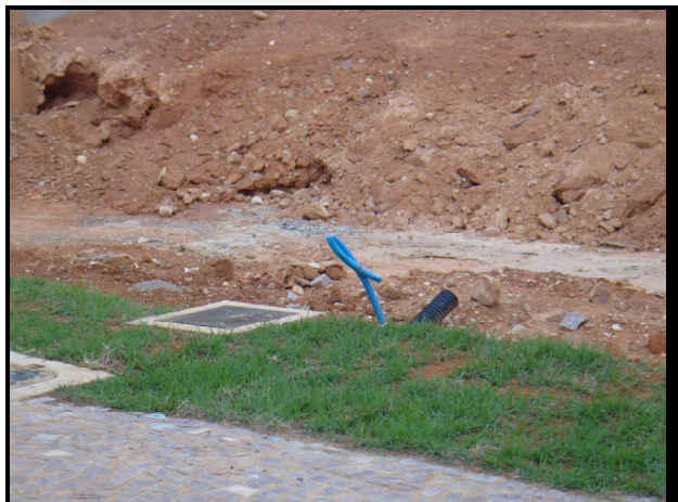
Foto 03. Detalhe da infraestrutura.
