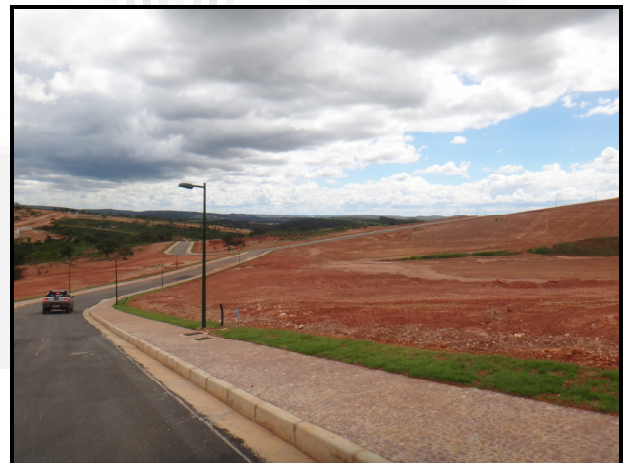
Foto 04. Detalhe da iluminação viária.
