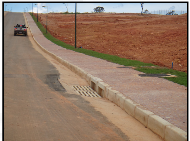
Foto 02. Detalhe da drenagem pluvial.
