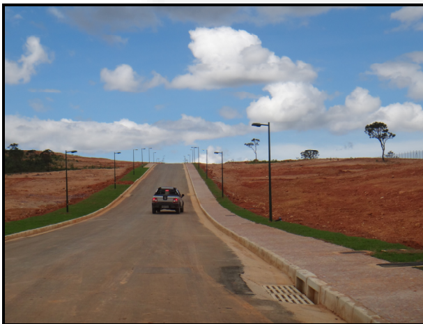
Foto 01. Vista da via implantada.
