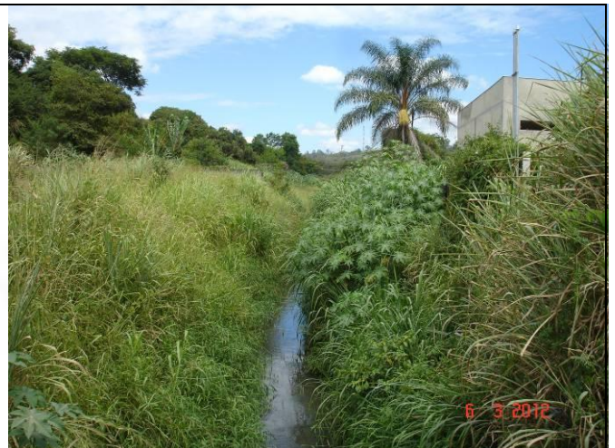
F2: Vista do córrego, de jusante para montante
