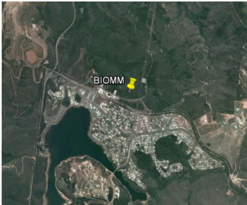
FIGURA 1 – Imagem da área preiteada para instalação do empreendimento. Fonte: Google Earth.
