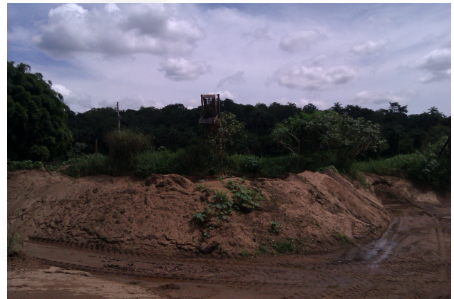
Foto 02. Detalhe da deposição de areia
