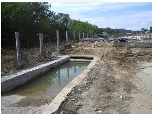
**Foto 3:** Bacia de sedimentação final para lançamento dos efluentes no Ribeirão da Mata
