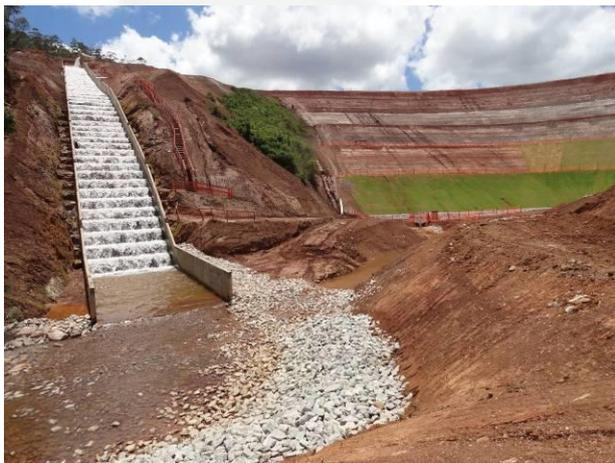
**Foto 03.** Vista inferior do vertedouro na ombreira direita do maciço da barragem Maravilhas II.
