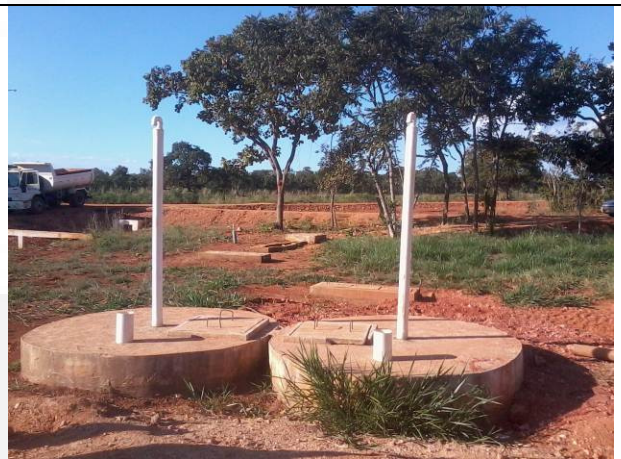
Foto 04 – Estruturas de coleta de chorume
