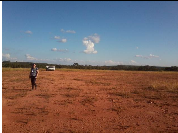
Foto 05 – Parte superior do aterro controlado
