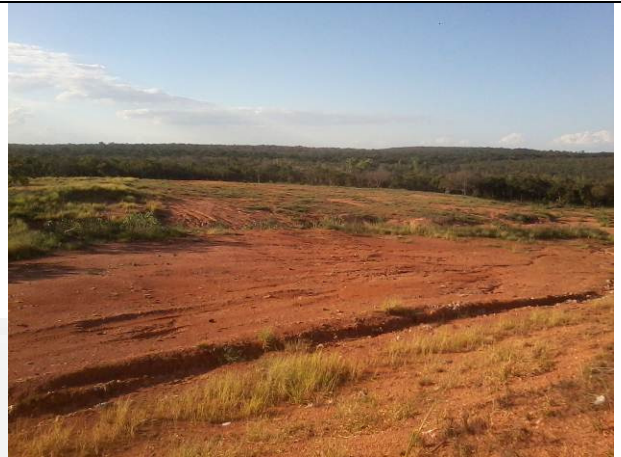
Foto 06 – Talude e entorno do aterro controlado
