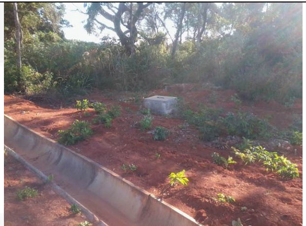
Foto 02- Canaleta de drenagem pluvial, poço de monitoramento de água subterrânea e cerca viva
