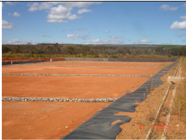
Foto 01- Plataforma do aterro (out/2012)
