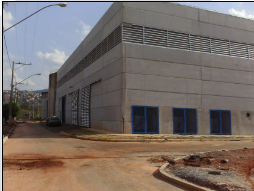
Foto 01: Vista externa da Pequena Central Termoelétrica
