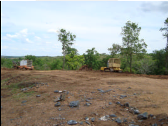
Foto 03. Atividade de decapeamento da jazida e retirada de solo vegetal.
