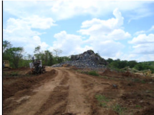
Foto 04. Continuação da Foto 03 e resultado do fogo de levante no maciço de calcário aflorante.
