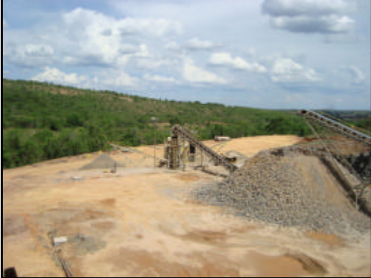
Foto 01. Vista da UTM e pátio de estocagem de minério beneficiado.
