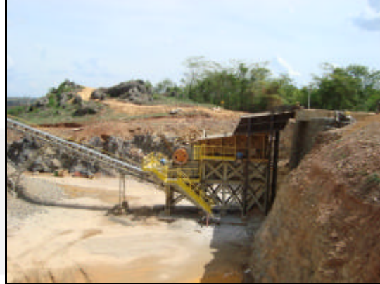
Foto 02. Continuação da foto 01 com detalhe do chute e britador.
