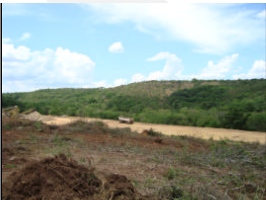
Fig 05. Vista de parte da UTM e pátio de estocagem de minério beneficiado.
