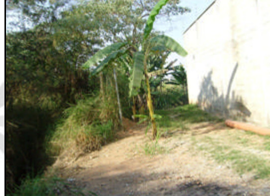
Foto 04. Muro da ETA em APP de curso d'água.
