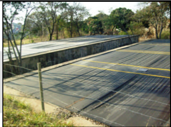
Foto 20. Antiga ETE com telas de proteção.
