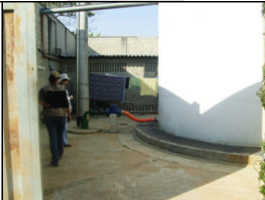
Foto 05. Poço tubular ligado à ETA.
