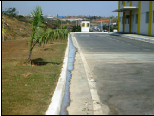
Foto 13. Escoamento superficial de água de lavagem do piso – PRODAL.
