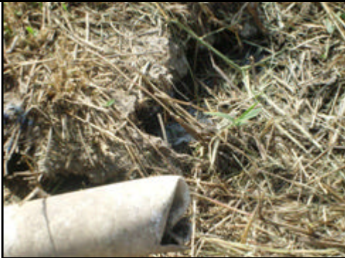
Foto 11. Vazamento de efluente in natura – ASMAC.
