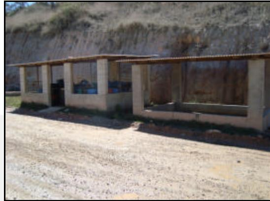
**Foto 10.** Armazenamento temporário de resíduos contaminados (esquerda) e caixa separadora de água/óleo.
