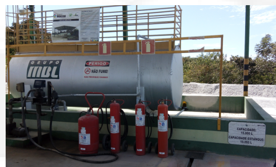
Foto 06. Área de abastecimento de veículos.
