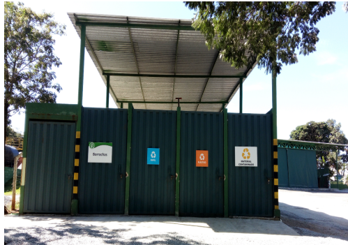
Foto 07. Armazenamento temporário de resíduos.
