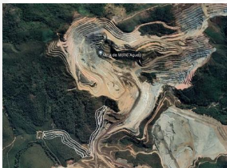
Figura 2.4 - Localização da alternativa 3 para os acessos da Cava Morro Agudo à expansão da PDE Nova Cururu. Fonte IC 2022
