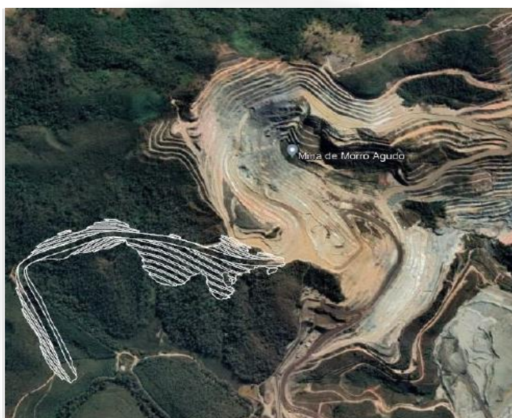
Figura 2.2 - Localização da alternativa 1 para os acessos da Cava Morro Agudo à expansão da PDE Nova Cururu. Fonte: Informações Complementares, 2022.
