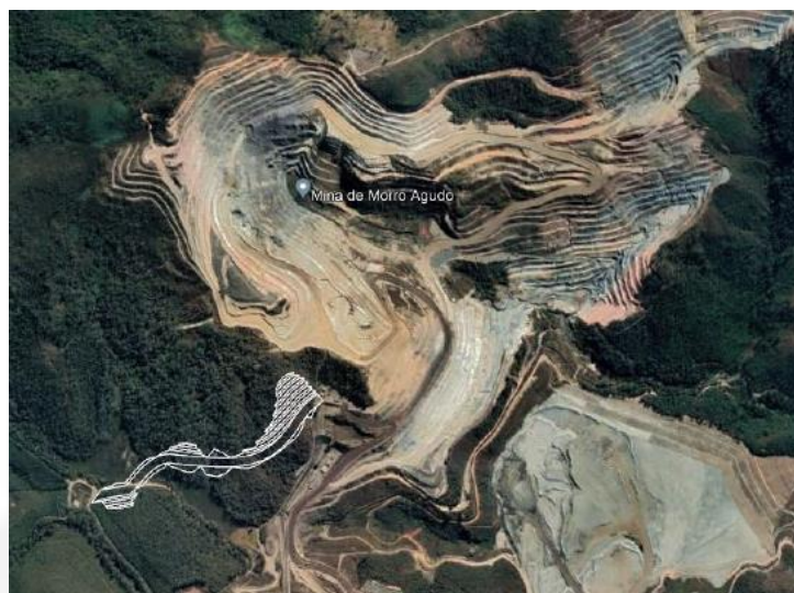
Figura 2.3 - Localização da alternativa 2 para os acessos da Cava Morro Agudo à expansão da PDE Nova Cururu. Fonte: Informações Complementares, 2022.
