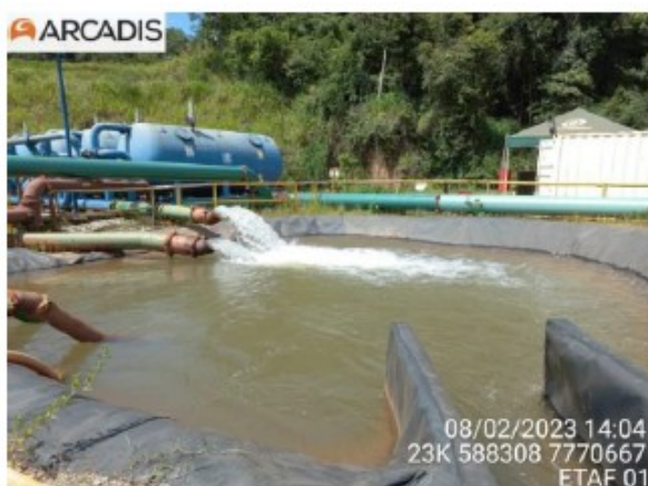
Ponto de coleta de efluente ETAF1-Saída (fev/23).
