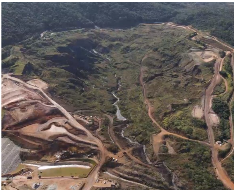
Figura 41: Barragem B-I (direita) com remanescentes de rejeito ao lado da Barragem B-VI (esquerda). (Fonte: MP-MG/Aecom, reunião de 15/06/2023 ).
