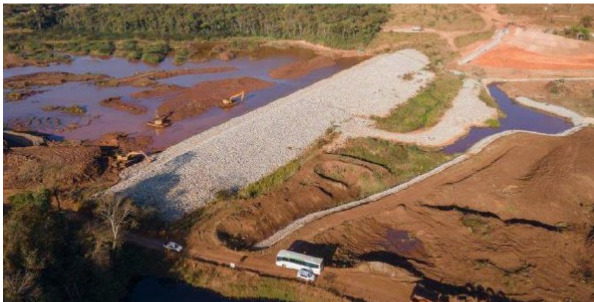
Figura 12: Vista de jusante para montante da BH1 em operação (Fonte: Vale - PMR, maio/2023 ).
