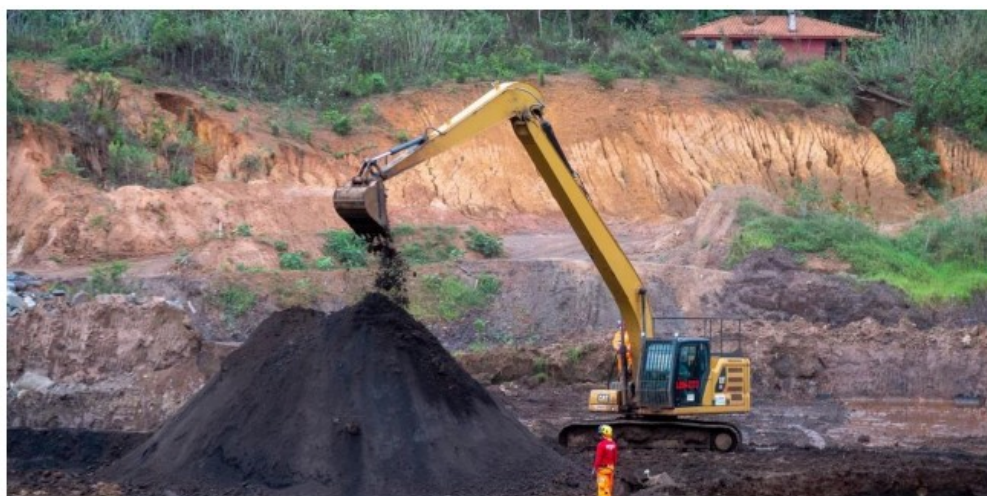
Figura 20: Área da Zona Quente: Inspeção visual de rejeitos pelos militares do CBMMG . (Fonte: Vale - IC, nov/2021).
