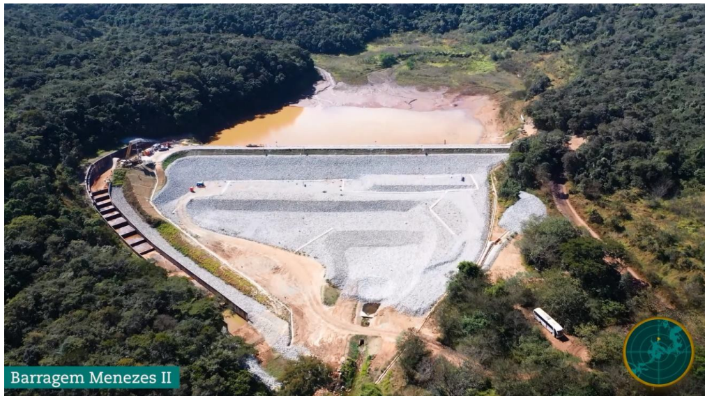
Figura 43: Vista da Barragem Menezes II, após as obras de estabilização geotécnica. (Fonte: Vale - IC nov/2021).
