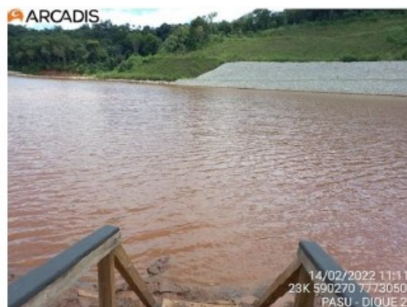
Ponto de monitoramento de água superficial PASU-DIQUE2 (fev/22).
