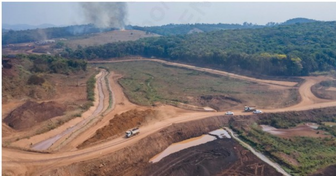
Figura 16: Segmento 1 - Canal de Desvio Jusante Dique 2 (margem esquerda). (Fonte: Vale - Plano de Manejo de Rejeito, maio/2023 ).
