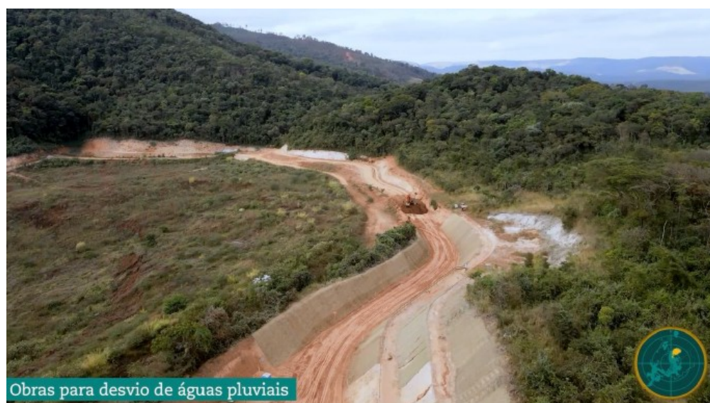
Figura 40: Canal periférico no entorno do antigo reservatório da Barragem B-I. (Fonte: Vale - IC nov/2021).
