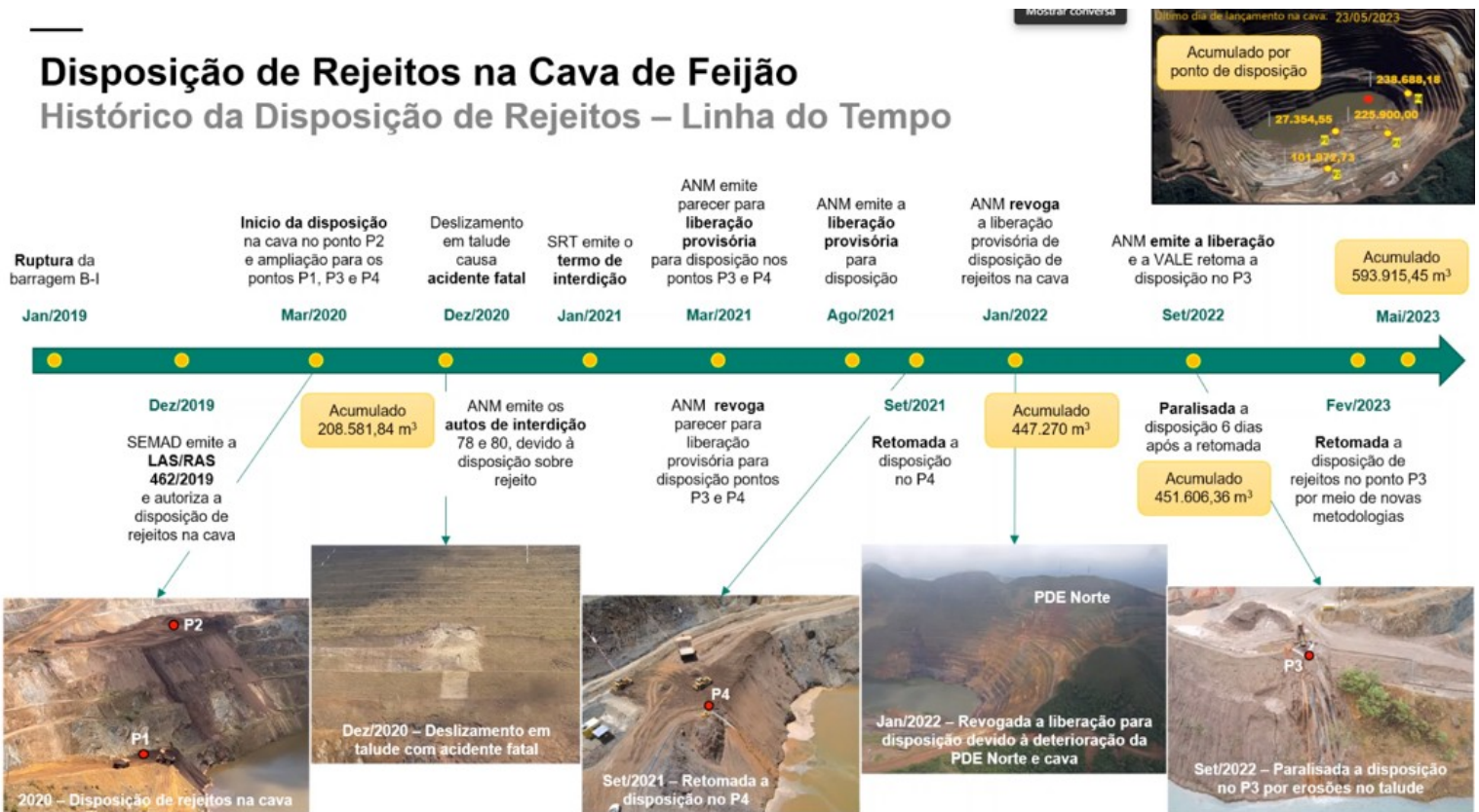
Figura 30: Histórico da disposição de rejeitos na Cava de Feijão. (Fonte: MP-MG/Aecom, reunião de 15/06/2023).
