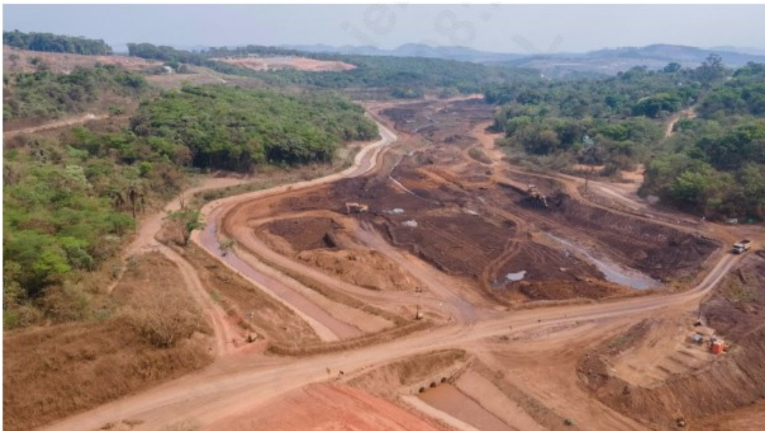
Figura 18: Segmento 3 - Canal de Desvio Jusante BH 1 (margem esquerda). (Fonte: Vale - Plano de Manejo de Rejeito, maio/2023 ).
