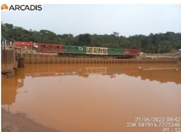
Ponto de monitoramento de água superficial PT-12 (jun/22).
