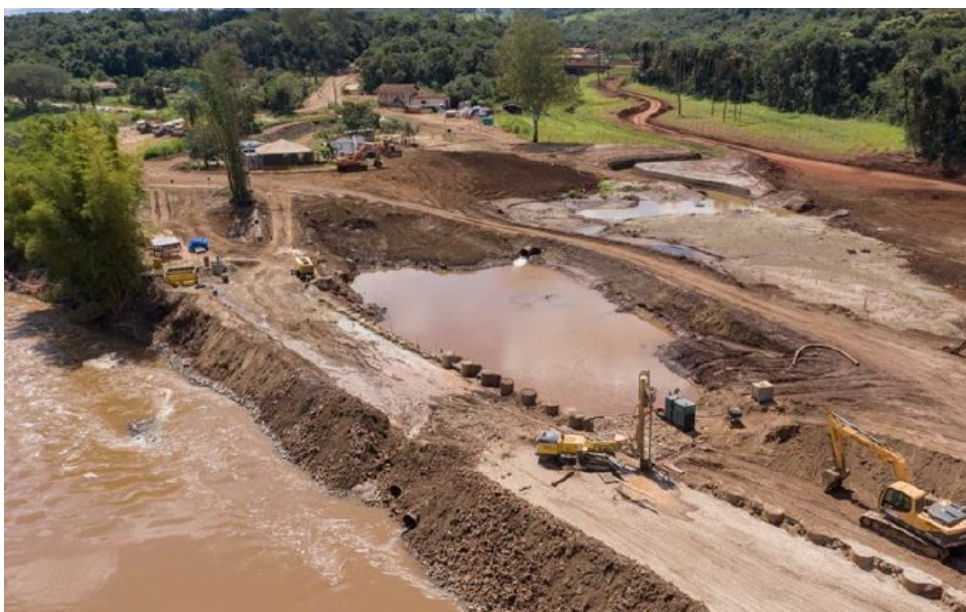
Figura 33: Obras da Cortina Metálica em Estaca Prancha EP-02. (Fonte: Vale – IC. nov/2021).
