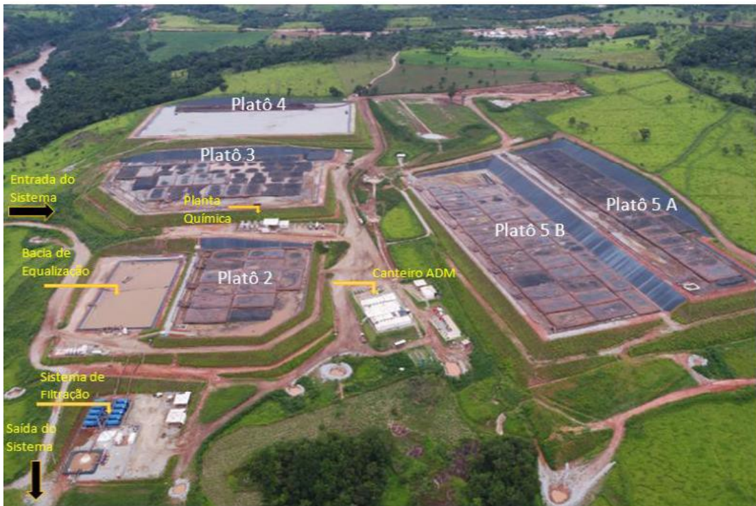
Figura 38 : EAF 2 - Vista geral dos compartimentos da ETAF2. (Fonte: Vale - IC nov/2021).
