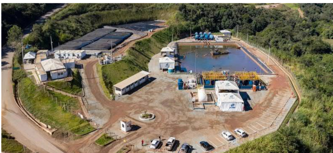
Figura 19: Situação da ETAF1 em operação . (Fonte: Vale - Plano de Manejo de Rejeito, maio/2023 ).
