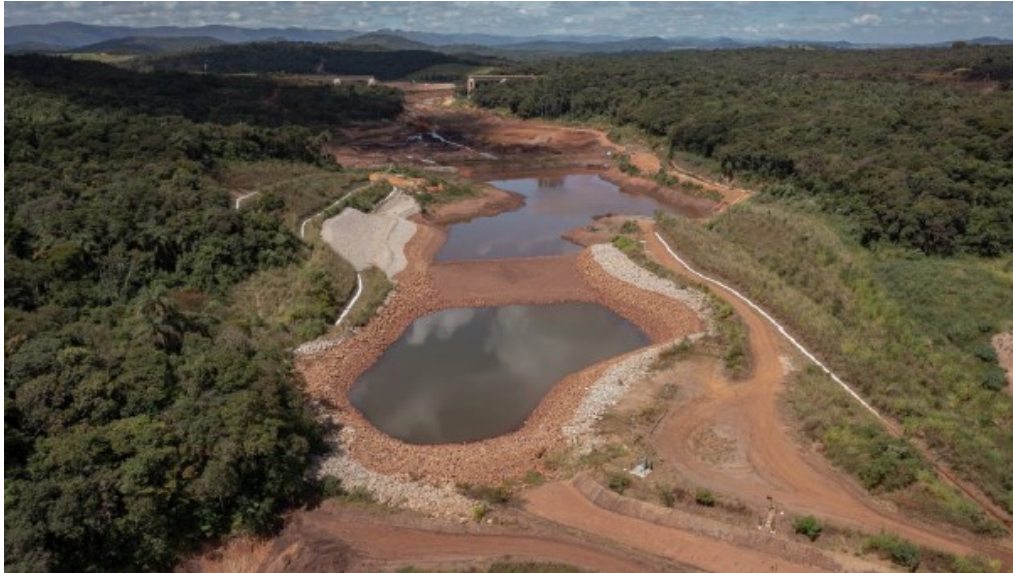
Figura 11: Situação do Dique 2 em operação. (Fonte: Vale - Plano de Manejo de Rejeito , maio/2023 ).
