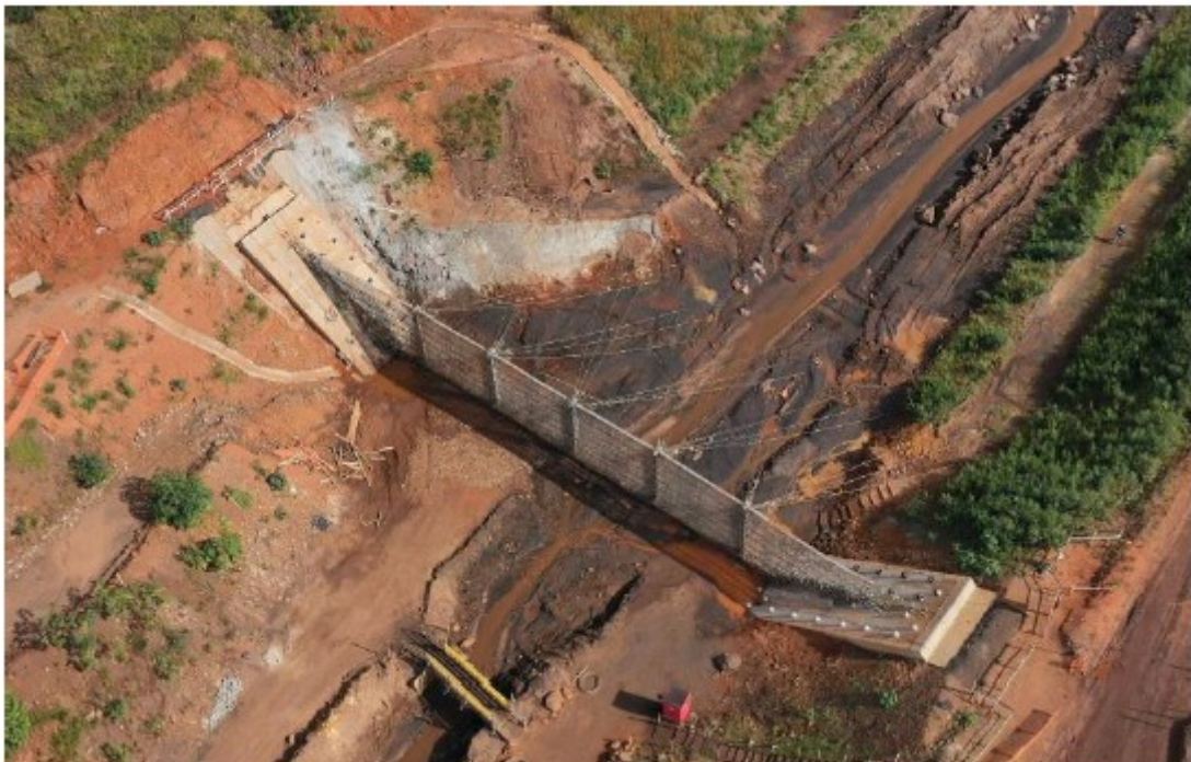
Figura 8: Vista aérea da barreira dinâmica (malha 03) em implantação. (Fonte: Vale - Plano de Manejo de Rejeitos, maio/2023 ).
