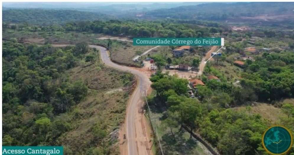
Figura 50: Estrada de acesso às comunidades de Córrego do Feijão e Cantagalo. (Fonte: Vale – IC, nov/2021).
