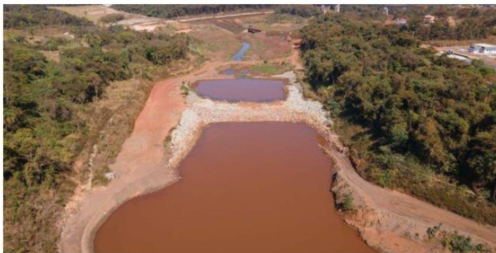
Figura 10: Situação da BH 0 em operação. (Fonte: Vale - Plano de Manejo de Rejeito , maio/2023).
