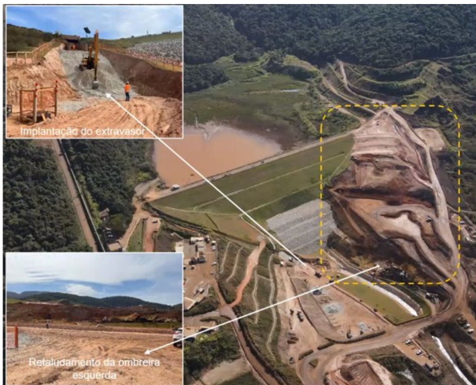
Figura 44: Barragem B-VI. (Fonte: MP-MG/ Aecom, reunião de 15/06/2023).
