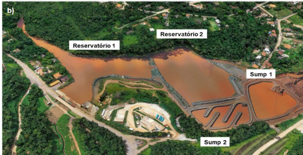
Figura 15: Reservatório e Sumps da EP-01 – junho de 2022. (Fonte: Vale - Plano de Manejo de Rejeito, maio/2023 ).
