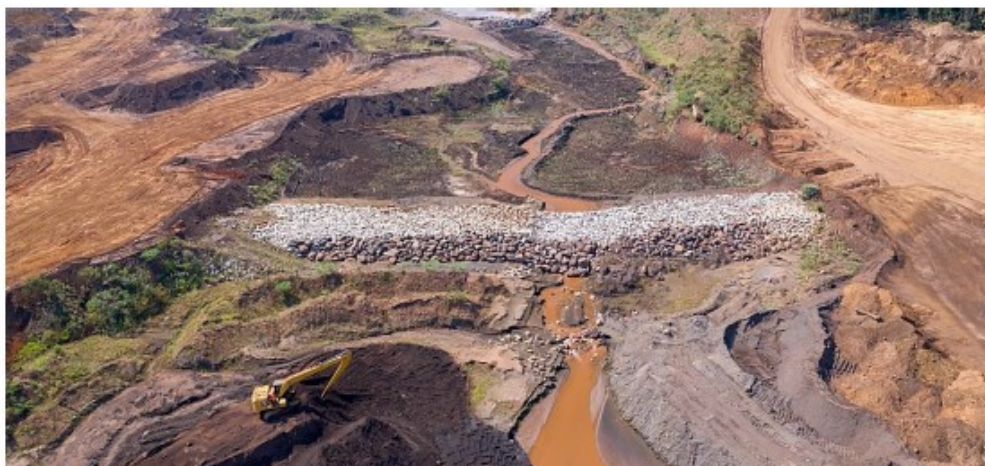
Figura 7: Formação de BEC com a disposição dos blocos na calha do ribeirão Ferro-Carvão. (Fonte: Vale - Plano de Manejo de Rejeito, maio/2023).
