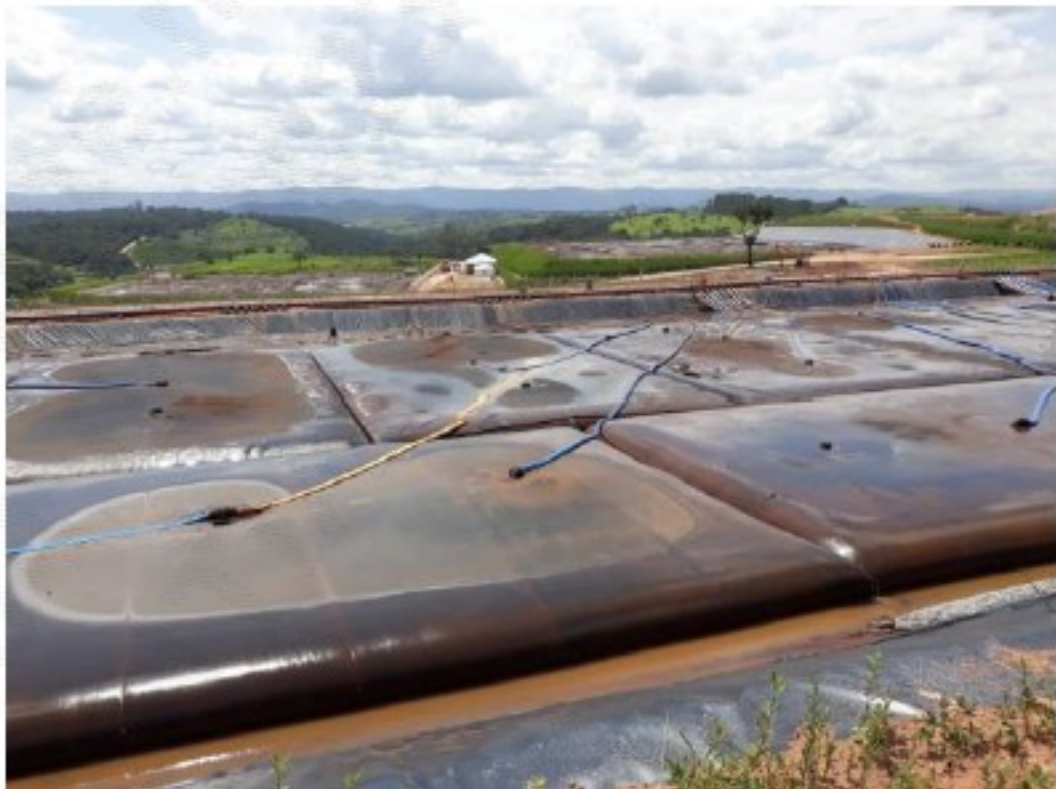
Figura 39: ETAF 2 Platô onde se encontram os geobags usados para disposição do sedimento/rejeito dragado. (Fonte: Vale - IC nov/2021). Desde 25/11/2021 o recebimento de rejeito está paralisado.
