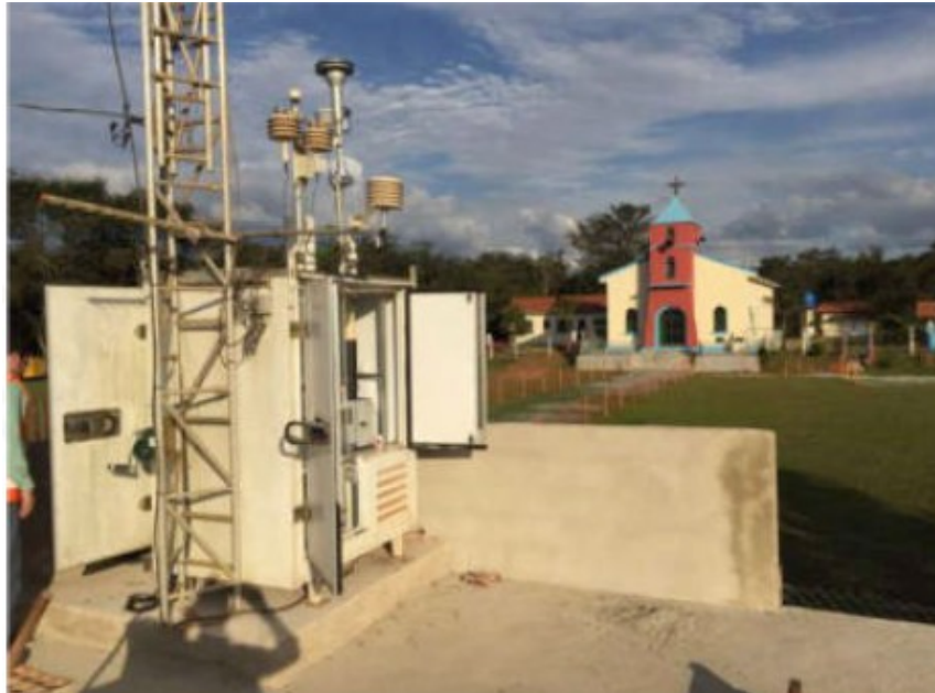
Figura 55: Estação convencional em Córrego do Feijão. (Fonte: Vale - PRSA, março/2022).
