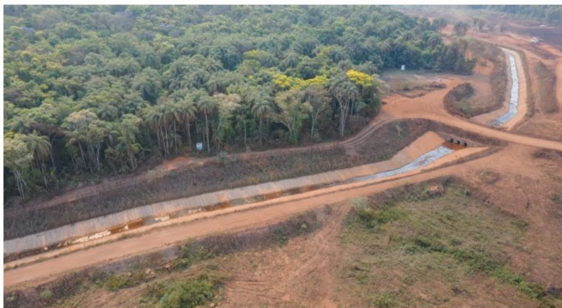
Figura 17: Segmento 2 - Canal de Desvio Jusante Dique 2 (margem direita). Fonte: Vale - Plano de Manejo de Rejeito, maio/2023 ).
