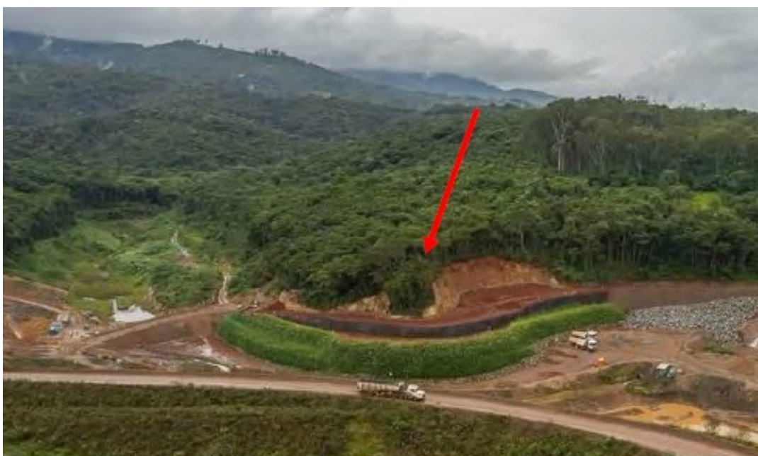
Figura 47: Obras de contenção da erosão no talude do córrego Samambaia. (Fonte: Projeto de Intervenção Ambiental - PIA córrego Samambaia, jan/2023).
