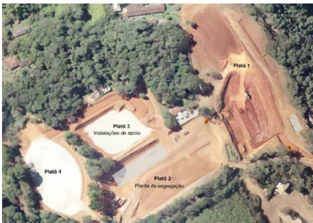
Figura 53: Plantas de Segregação da Central de Materiais Descartáveis CMD. (Fonte: SUPPRI, julho/2023 ).
