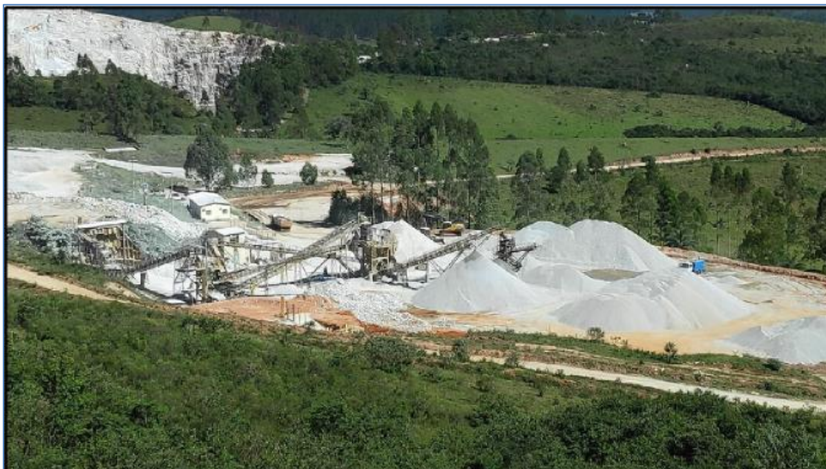
Figura 04 – Vista da unidade de tratamento de minérios em atividade (Fonte: RCA)
