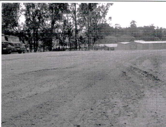
Pátio de carregamento de brita sem asfaltamento
