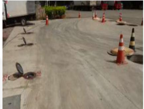
Foto 02. Área de tancagem
