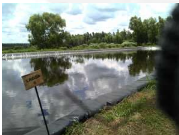
Lagoa de tratamento de efluentes
