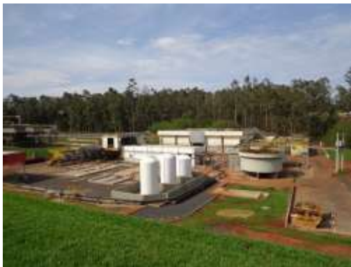
Vista parcial da ETE
