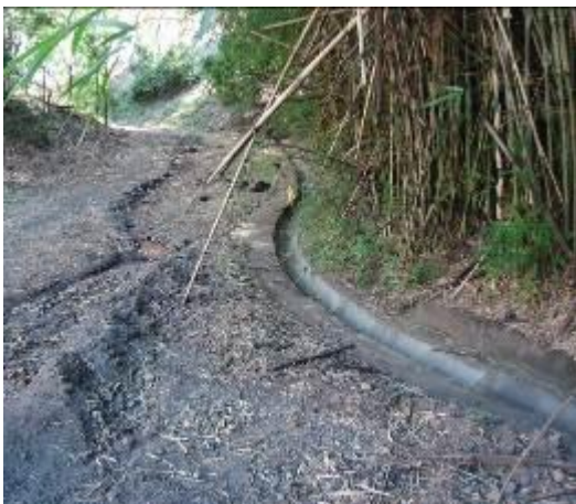
Foto 07. Canaletas para drenagem pluvial.
