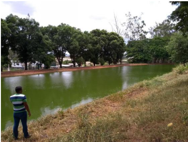
Foto 15 - Lagoa de estabilização
