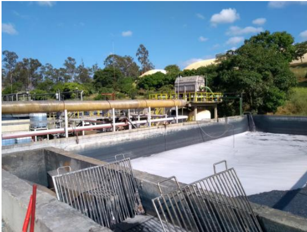
Foto 9 - Gradeamento/Equalizador ETE
