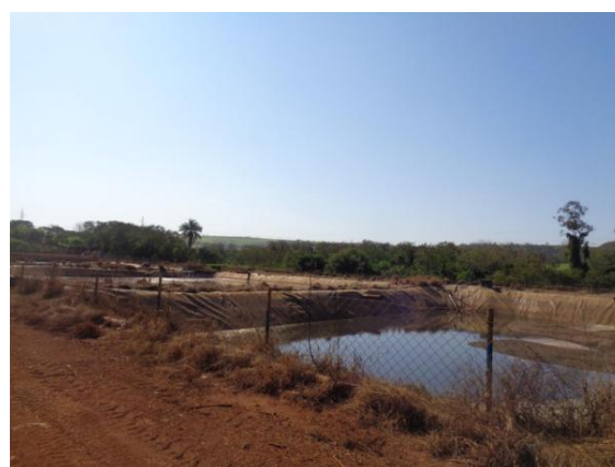
Figura 4- Reservatórios de vinhaça/águas residuárias
