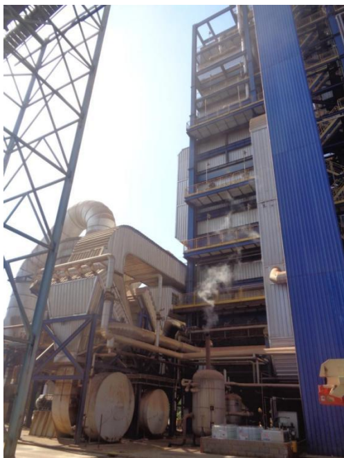
Figura 5- Caldeira e lavador de gases
