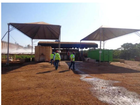
Figura 3-Central de recebimento de resíduos
