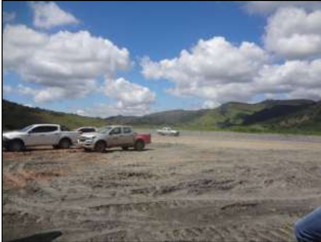
Foto 05 – Vista da pilha de rejeito/estéril licenciada via LOC n.º 007/2015.
