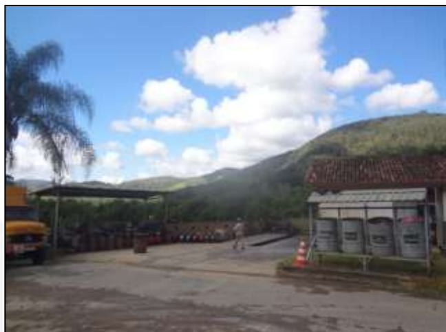
Foto 10 – Lavador de máquinas e veículos. Observa-se ainda recipientes para separação dos resíduos sólidos gerados e estrutura para deposição de barris com óleo usado.
