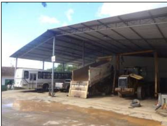
Foto 09 – Oficina para manutenção de máquinas e equipamentos.
