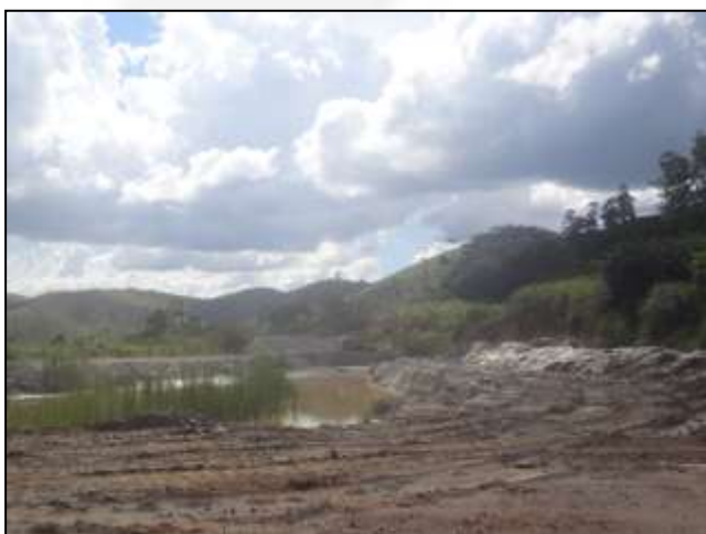
Foto 11 – Vista parcial do sistema de tratamento (diques de decantação) do rejeito oriundo da UTM. Como destacado no parecer, cerca de 22% do rejeito é destinado a esses diques, sendo que o restante, após a peneira desaguadora, vai diretamente para a pilha. Observa-se que à direita encontra-se material retirado dos diques por retroescavadeira, o qual permanece neste local até secagem e posterior encaminhamento à pilha.
