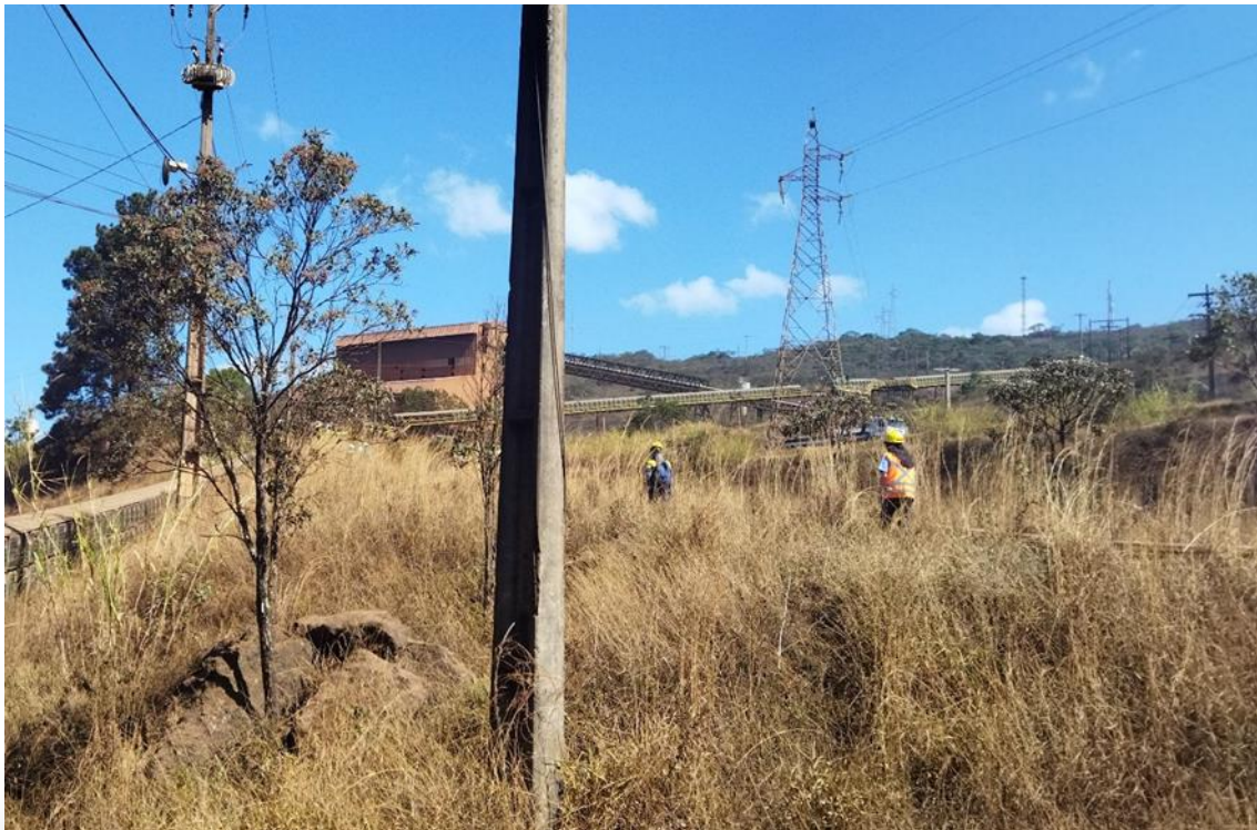
Fonte: SUPPRI – Vistoria, 2022
