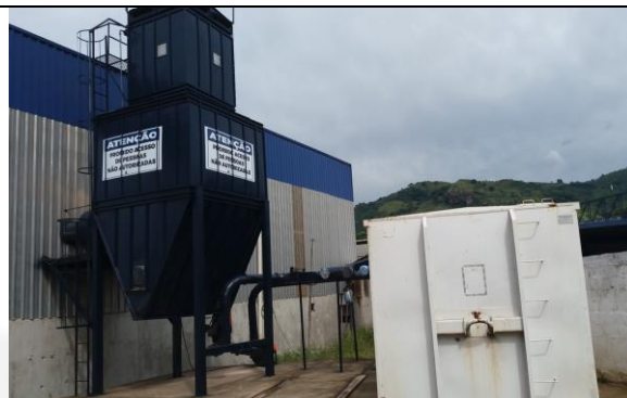
Figura 06: Silo de armazenamento de pó de madeira
