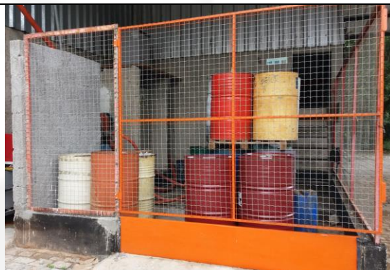
Figura 04: Depósito de produtos químicos isolado, coberto, piso impermeabilizado e com bacia de contenção.
