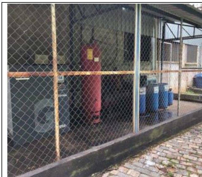
Figura 11: Sistema de compressores do setor de produção de espuma.
