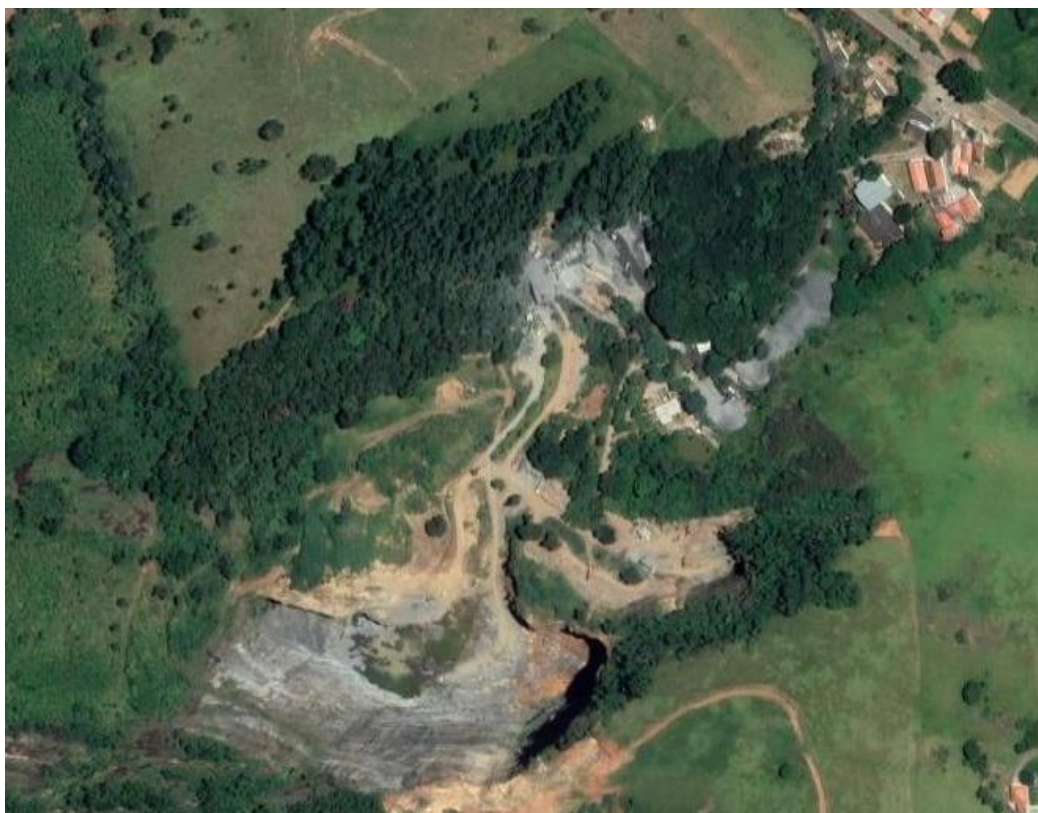
Figura 1 - Imagem aérea do empreendimento
