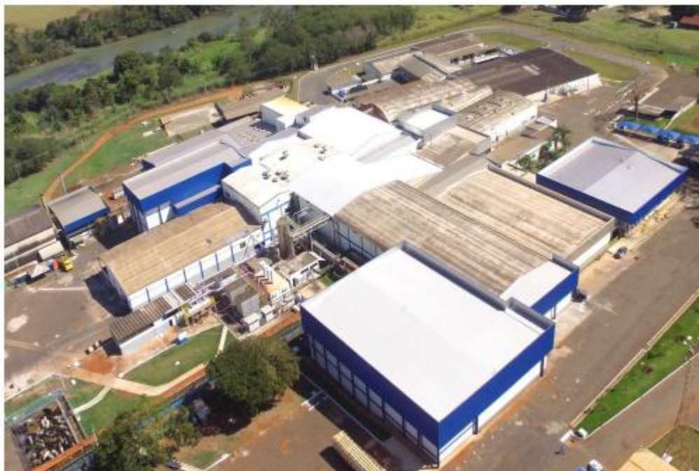
Vista da área industrial JBS S.A. (Unidade de Ituiutaba- MG)
