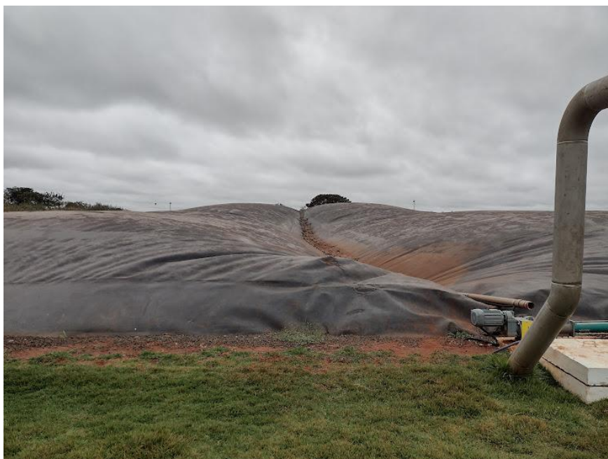
Foto Vistoria: Biodigestor existente na ETE
