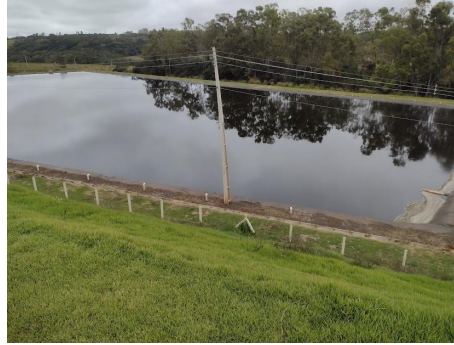
Lagoa de Tratamento
