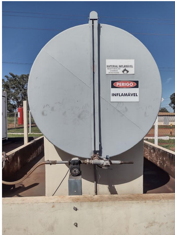
Foto vistoria: Tanque de Diesel existente
